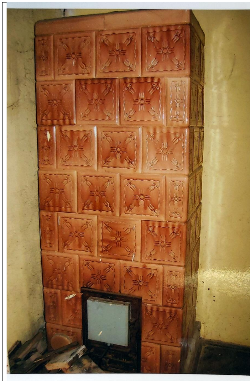
Fot. 3/VII.C. Piec kaflowy, wg dokumentacji z 2014 r., znajdujący się w pomieszczeniu 2.9, obecnie piec nie istnieje, materiał z rozbiórki w stanie nieuporządkowanym. Wymagana pilna ocena stanu i kompletności elementów pieca. Budynek „Kossakówka, Pl. Kossaka 4, Kraków . Fotografia po lewej pochodząca z opracowania: A.Zdyra, K. Gabryś-Cichacz "Program konserwatorski Willa Kossakówka, Plac Kossaka 4, Kraków" oraz "Zestawienie elementów zabytkowych do zachowania", Kraków 2014 r., znajdującego się w archiwum WUOZ w Krakowie. Fot. poniżej: D. Narowska Avonza, luty 2021 r.
