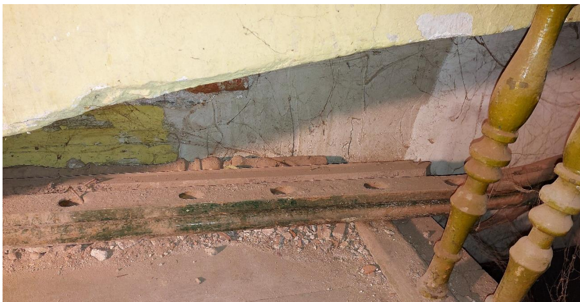
Fot. 33. Zdemontowane i złożone obok zachowanego fragmentu balustrady części pochwytu oraz trzy tralki. Budynek „Kossakówka, Pl. Kossaka 4, Kraków. Fot. D. Narowska Avonza, luty 2021.
