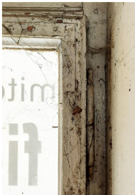
Fot. 23. Elementy okucia okna oznaczonego I 03. Pokryte warstwami farb: historyczny zawias czopowy, oraz wzmocnienie łączenia ramiaków z blaszki kątovej. Budynek „Kossakówka, Pl. Kossaka 4, Kraków. Fot. D. Narowska Avonza, luty 2021
