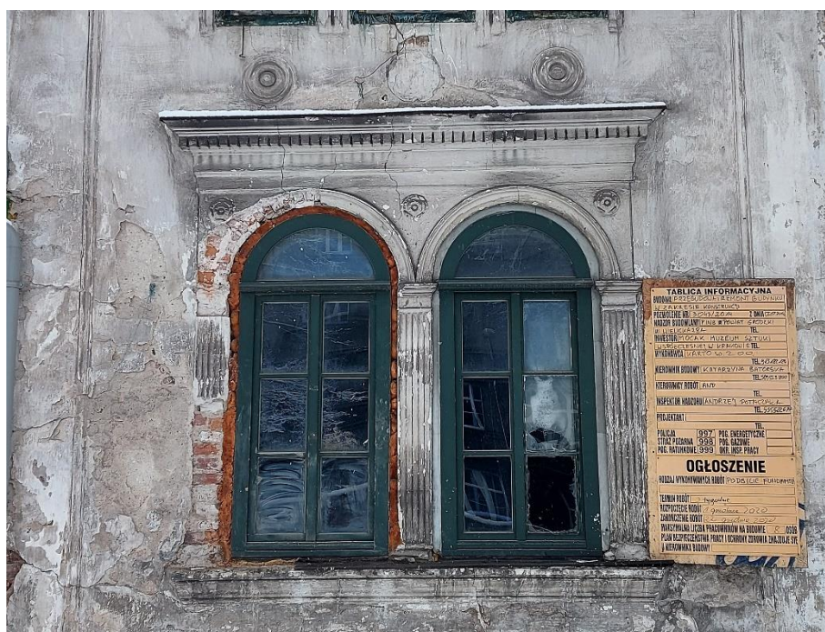
Fot. 12. Fragment środkowej części elewacji południowej. Budynek „Kossakówka, Pl. Kossaka 4, Kraków Ubytki dekoracji architektonicznej, brak środkowej rozetki wraz z otaczającym ją tynkiem, rozległe ubytki obramienia biforium. Bardzo zły stan murów i tynków, spowodowany przez wilgoć, wysolenia oraz mikroorganizmy i glony. Fot. D. Narowska Avonza, luty 2021 r.
