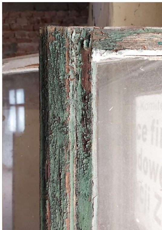
Fot. 25. Fragment okna oznaczonego I 03. Widoczne praktycznie całkowite odspojenie się warstwy malarskiej w formie drobnych łusek, w miejscach ubytków widoczne zawilgocone drewno ramiaka. Budynek „Kossakówka, Pl. Kossaka 4, Kraków. Fot. D. Narowska Avonza, luty 2021
