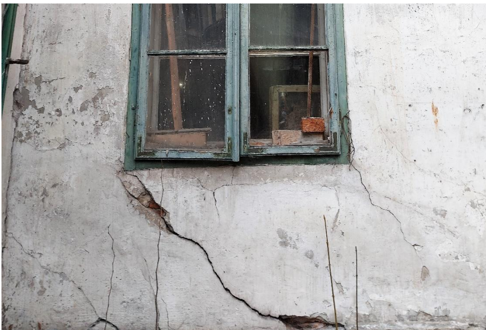
Fot. 5. Budynek „Kossakówka, Pl. Kossaka 4, Kraków . Widok fragmentu elewacji wschodniej. Bardzo zły stan murów i tynków, widoczne ubytki tynku. Głębokie pęknięcia pod oknem, widoczne także od wewnątrz budynku. Fot. D. Narowska Avonza, luty 2021 r.
