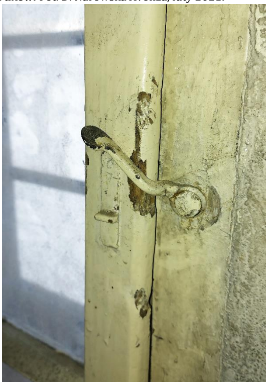
Fot. 22. Element okucia okna oznaczonego I 08. Pokryta warstwami farb historyczna zakrętka. Budynek „Kossakówka, Pl. Kossaka 4, Kraków. Fot. D. Narowska Avonza, luty 2021
