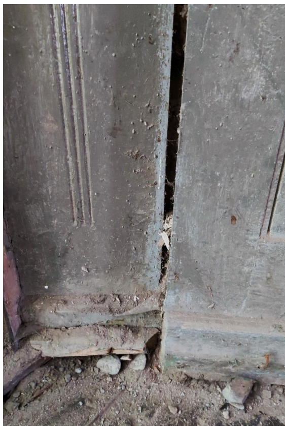
Fot. 35. Drewniana historyczna boazeria, fragment dolnej części, widoczny zły stan zachowania Budynek „Kossakówka, Pl. Kossaka 4, Kraków. Fot. D. Narowska Avonza, luty 2021
