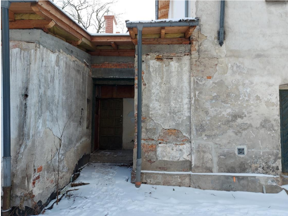
Fot.2. Budynek „Kossakówka, Pl. Kossaka 4, Kraków. Widok fragmentu elewacji północnej. Bardzo zły stan murów i tynków, widoczne liczne ubytki tynków i fatalny stan pozostałych na elewacji wypraw tynkarskich. Fot. D. Narowska Avonza, luty 2021 r.
