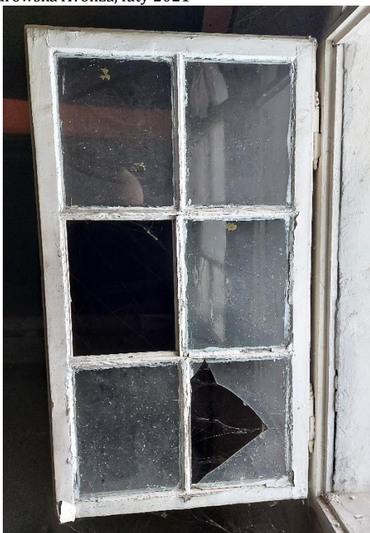
Fot. 26. Widok wewnętrznego skrzydła okna oznaczonego I 08. Bardzo zły stan, braki w oszkleniu, spękany i wykruszony kit szklarski, zły stan powłok malarskich. Budynek „Kossakówka, Pl. Kossaka 4, Kraków. Fot. D. Narowska Avonza, luty 2021
