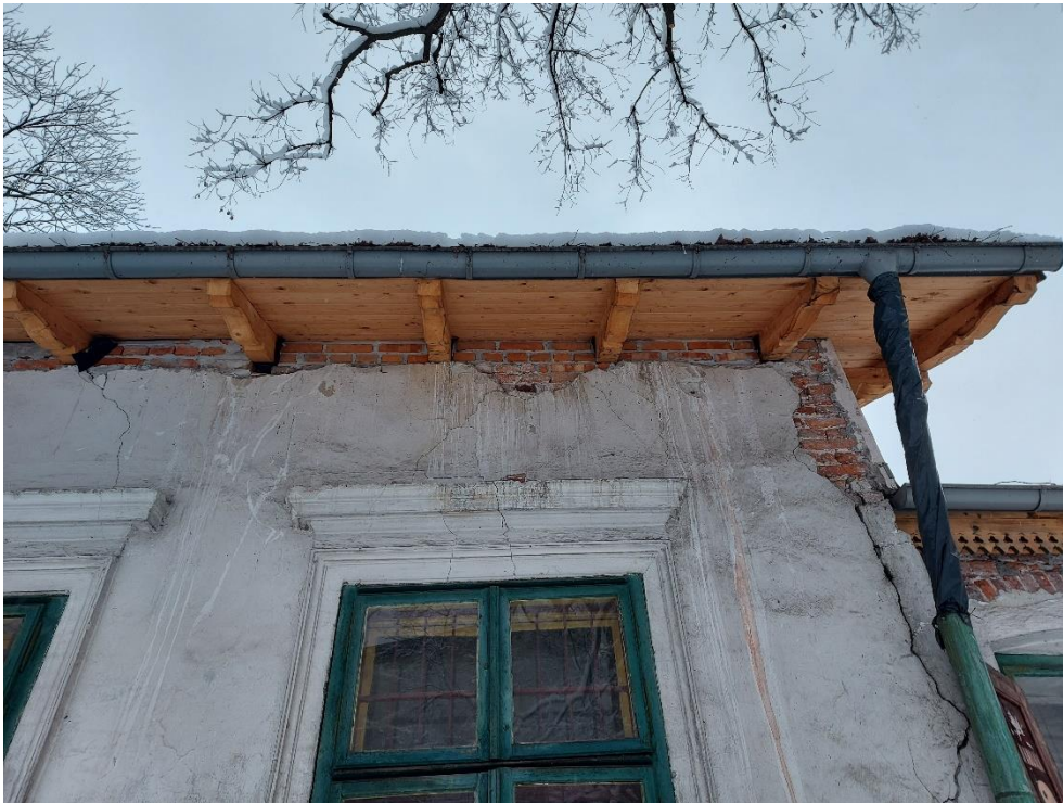
Fot. 4. Budynek „Kossakówka, Pl. Kossaka 4, Kraków . Widok fragmentu elewacji południowej. Bardzo zły stan murów i tynków, widoczne ubytki tynku. Głębokie pęknięcia w narożniku budynku. Fot. D. Narowska Avonza, luty 2021 r.
