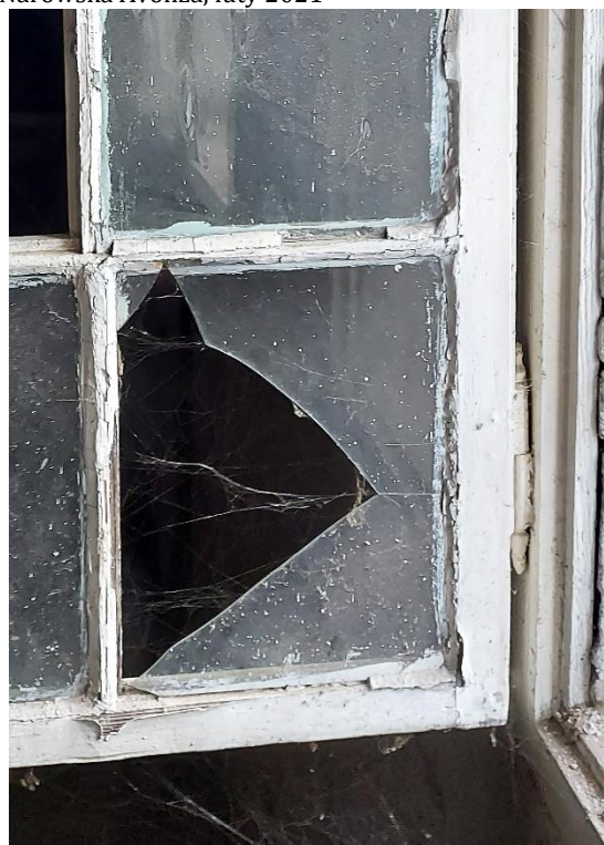
Fot. 27. Fragment okna oznaczonego I 08. Bardzo zły stan skrzydła okiennego, braki w oszkleniu, spękany i wykruszony kit szklarski, zły stan powłok malarskich. Widoczny historyczny zawias. Budynek „Kossakówka, Pl. Kossaka 4, Kraków. Fot. D. Narowska Avonza, luty 2021
