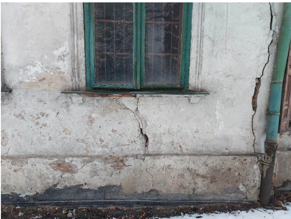
Fot. 3. Budynek „Kossakówka, Pl. Kossaka 4, Kraków. Widok fragmentu elewacji południowej. Bardzo zły stan murów i tynków, widoczne ubytki tynku w partiach przyziemnych i zawilgocenie. Głębokie pęknięcia konstrukcyjne pod oknem i w narożniku budynku. Fot. D. Narowska Avonza, luty 2021 r.
