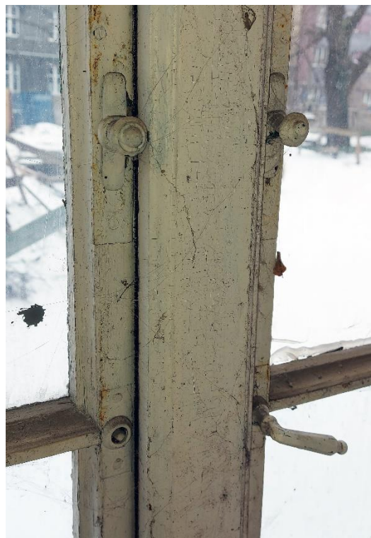
Fot. 21. Okucia okna oznaczonego I 04. Pokryte warstwami farb: odbojniki i część mosiężnej klamki. Brak klamki. Budynek „Kossakówka, Pl. Kossaka 4, Kraków. Fot. D. Narowska Avonza, luty 2021
