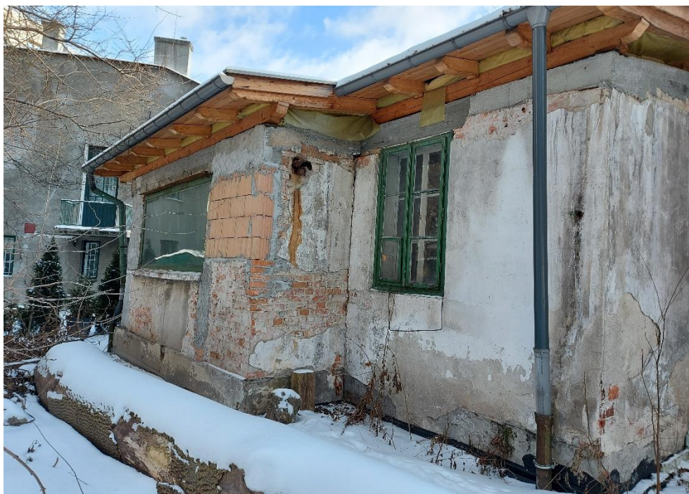
Fot. 1. Budynek „Kossakówka, Pl. Kossaka 4, Kraków. Widok fragmentu elewacji północnej. Bardzo zły stan murów i tynków, widoczne nowe przemurowania wykonane z pustaków ceramicznych i mocnej zaprawy cementowej. Fot. D. Narowska Avonza, luty 2021 r.
