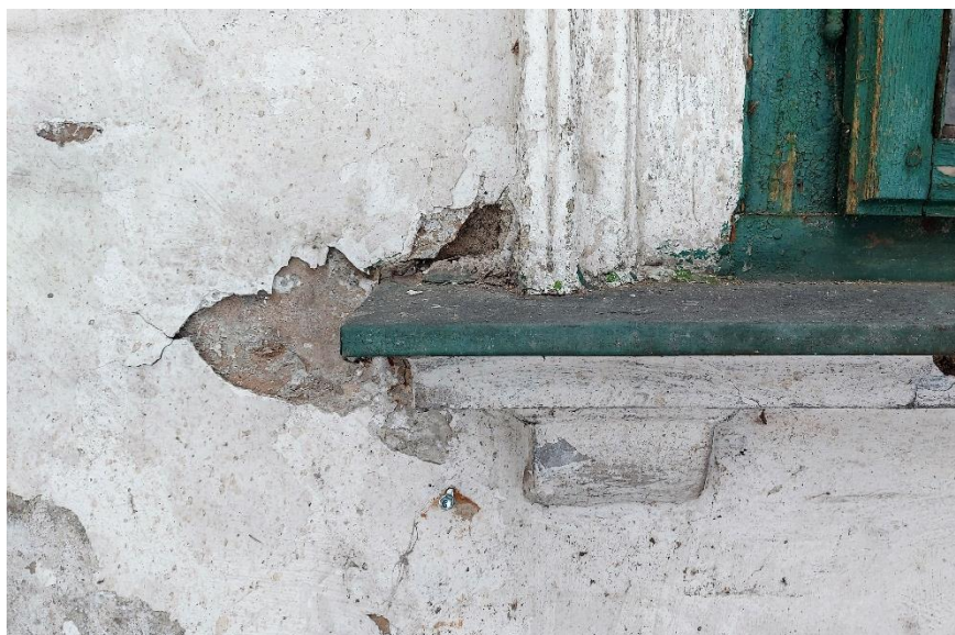
Fot. 8,9,10. Budynek „Kossakówka, Pl. Kossaka 4, Kraków. Widok fragmentów elewacji południowej. Bardzo zły stan murów i tynków, spowodowany przez wilgoć, wysolenia oraz dużą ilość nawarstwień. Fot. D. Narowska Avonza, luty 2021 r
