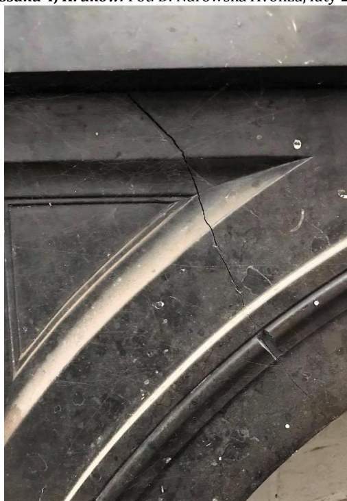
Fot. 39. Kominek z czarnego marmuru w pomieszczeniu nr 2.1, fragment. Widoczne pęknięcie ukośne oraz ubytek profilowania. Budynek „Kossakówka, Pl. Kossaka 4, Kraków. Fot. D. Narowska Avonza, luty 2021
