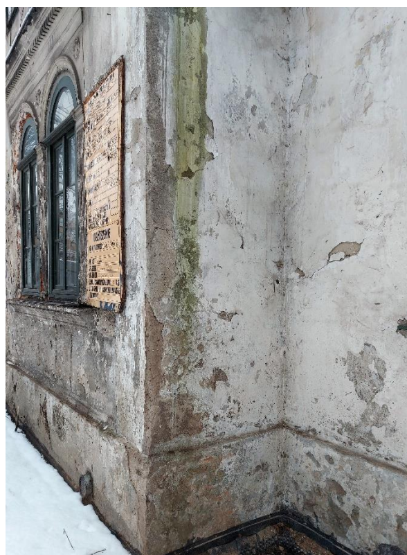
Fot. 6,7. Budynek „Kossakówka, Pl. Kossaka 4, Kraków. Widok fragmentów elewacji południowej. Bardzo zły stan murów i tynków, spowodowany przez wilgoć, wysolenia oraz mikroorganizmy i glony. Fot. D. Narowska Avonza, luty 2021 r.
