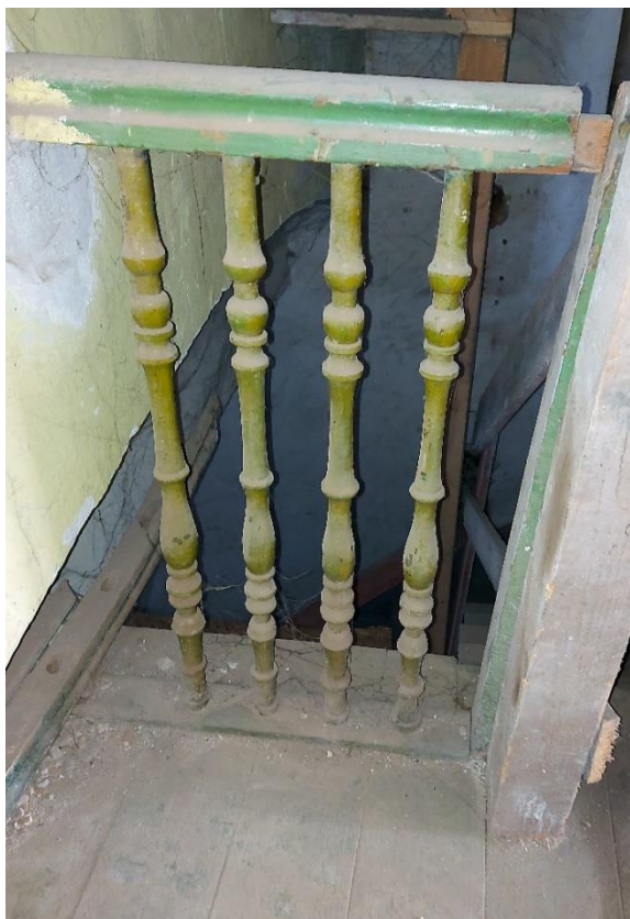
Fot. 31. Drewniana balustrada z pochwytym i słupkiem, jedyny zachowany fragment. Widoczne nawarstwienia malarskie oraz rozejście się połączenia pochwytu ze słupkiem. Budynek „Kossakówka, Pl. Kossaka 4, Kraków. Fot. D. Narowska Avonza, luty 2021.
