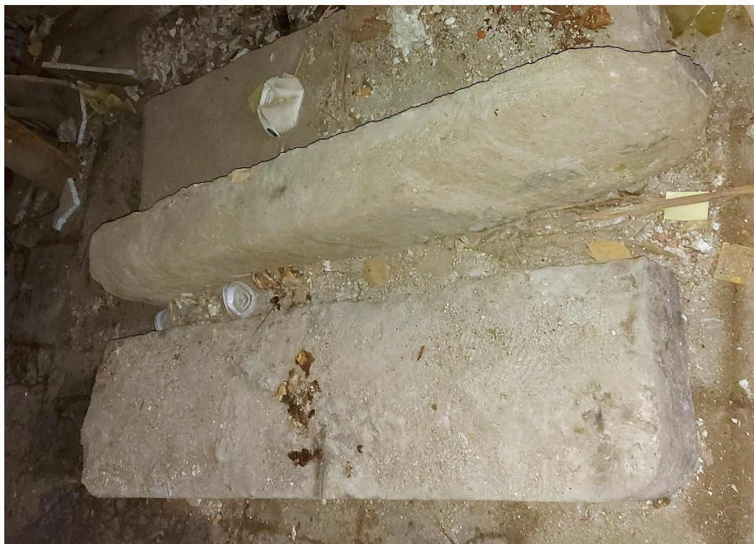
Fot. 16 Budynek „Kossakówka, Pl. Kossaka 4, Kraków . Widoczne zdemontowane stopnie z piaskowca w bardzo złym stanie. Fot. D. Narowska Avonza
