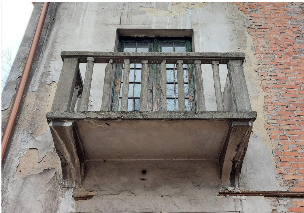
Fot. 15. Budynek „Kossakówka, Pl. Kossaka 4, Kraków . Żelbetowy balkon na elewacji zachodniej, bardzo zły stan wsporników i płyty, umiarkowania zły stan pochwyty i tralek. Widoczne fragmenty odsłoniętego zbrojenia, zacieki i spękania. Fot. D. Narowska Avonza
