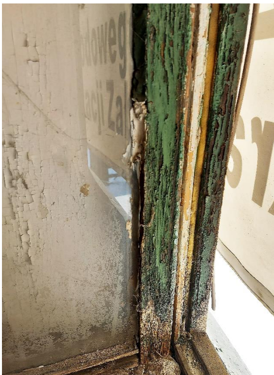
Fot. 24. Fragment okna oznaczonego I 03. Fatalny stan zarówno warstw malarskich, jak i drewna i kitów szklarskich. Drewno widoczne w miejscach ubytków warstwy malarskiej jest zawilgocone i zdeintegrowane. Budynek „Kossakówka, Pl. Kossaka 4, Kraków. Fot. D. Narowska Avonza, luty 2021
