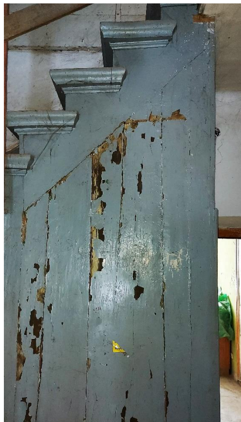
Fot. 29. Widok drewnianych schodów, liczne i rozległe ubytki warstwy malarskiej, odsłonięte drewno w bardzo złym stanie, zaatakowane zgnilizną brunatną.. Budynek „Kossakówka, Pl. Kossaka 4, Kraków. Fot. D. Narowska Avonza, luty 2021.
