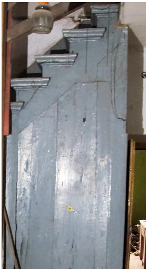
Fot. 28. Widok drewnianych schodów, powłoka malarska w kilku miejscach spękana, niewielkie ubytki – świadczące o postępującym procesie destrukcji drewna zachodzącej pod warstwami farby. Budynek „Kossakówka, Pl. Kossaka 4, Kraków. Fot. z archiwum MOCAK, wykonana w styczniu 2020.
