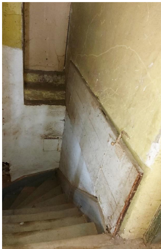
Fot. 32. Drewniany podnoszony trap, łączący spocznik schodów z pomieszczeniem 1.8, stan drewna wydaje się być dość dobry, widoczne zniszczenia mechaniczne powierzchniowe, gruba wielowarstwowa powłoka malarska. Budynek „Kossakówka, Pl. Kossaka 4, Kraków. Fot. D. Narowska Avonza, luty 2021.
